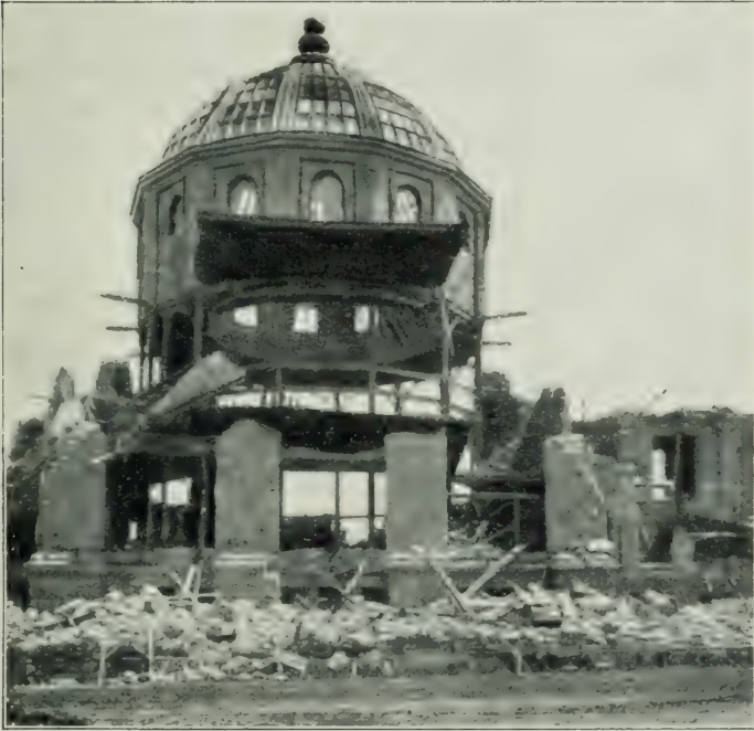
Fig. 14. Das Bibliotheks-Gebäude der Stanford-Universität in Kalifornien nach dem Erdbeben 1906. Das Bild zeigt die grosse Widerstandskraft der Eisenkonstruktionen, verglichen mit derjenigen von Mauerwerk. Die Einwirkung des Erdbebens auf hölzerne Konstruktionen ist auf Fig. 11 ersichtlich.
